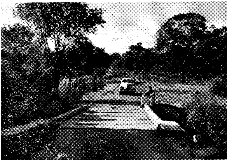
Estrada de rodagem recentemente construída no Mun. de Catalão — Goiás
